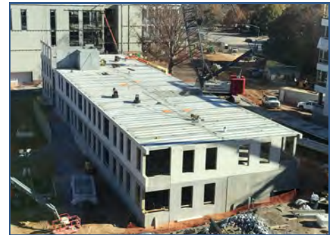
Bldg. D Precast
