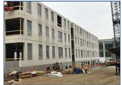
Bldg. D Precast
