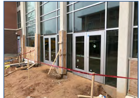
Bldg. E Storefront Doors
