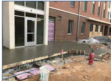
Bldg. F Door Stoop
