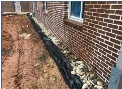
Bldg. G Drip Edge
