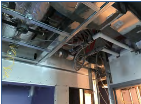
Bldg. A A-2 Rough In
