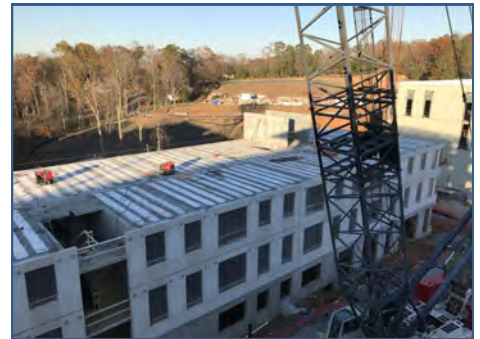
Bldg. D Precast
