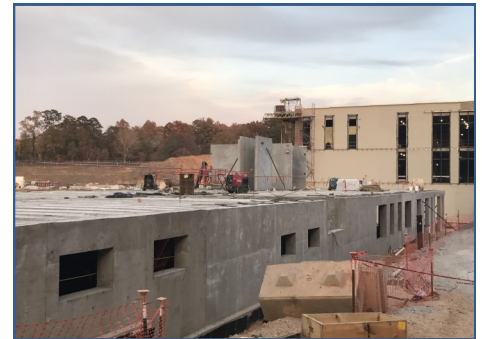
Bldg. D Precast
