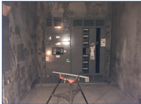
Bldg. B Switchgear
