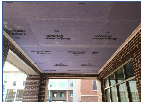
Bldg. F Exterior Soffit
