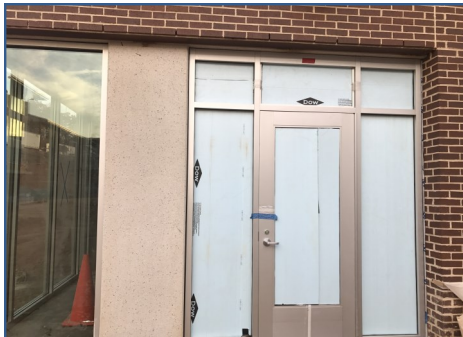
Bldg. G Storefront Door
