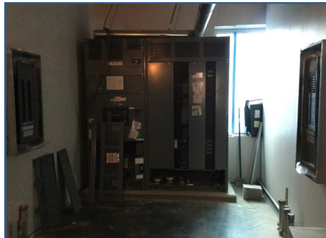
Bldg. E Switchgear
