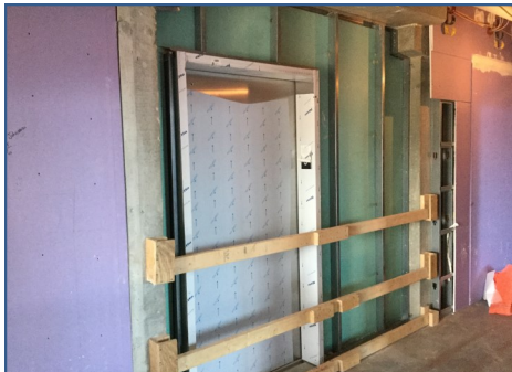
Bldg. G Elevator Door Framing
