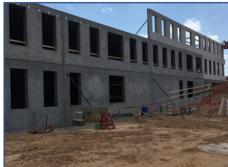
Bldg. B Precast
