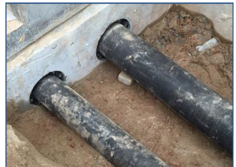
Bldg. F Water Tie Ins
