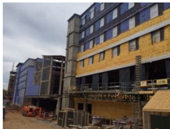
West - Bldg. A, B, & C
