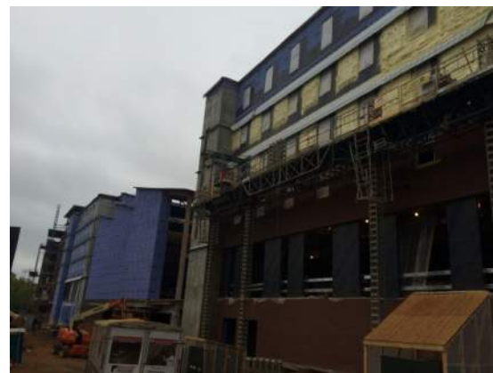
West - Bldg. A, B, & C
