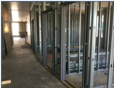
Bldg. G Door Frames
